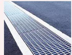
**コン太さん**：路面排水溝類の3番目に紹介する製品は、自由勾配側溝(縦断勾配可変側溝)だよ。
