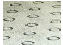
真空脱水させた コンクリート舗装面
