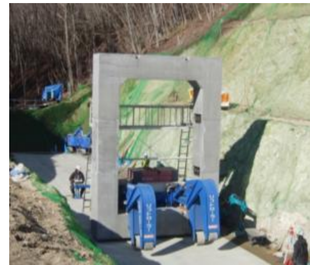
大型BOX施工状況
