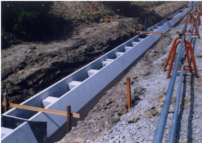
製品設置状況
