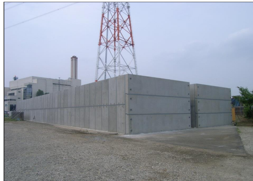
保管庫の外観
