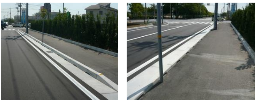
草止め Rain catch エプロン施工完了
