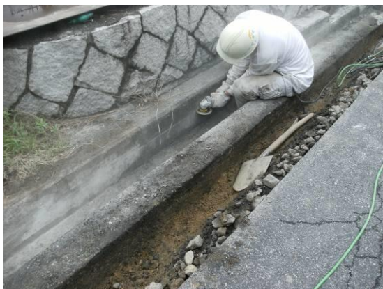
既設側溝上部の撤去状況
