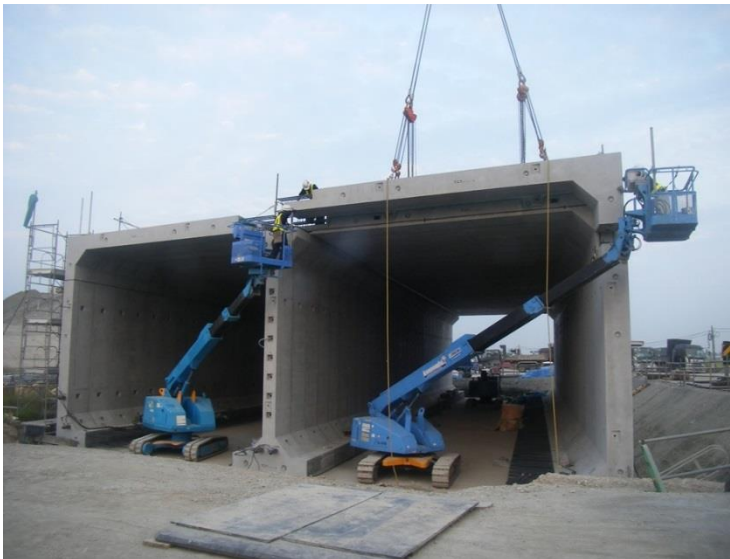
施工状況(製品据付)
