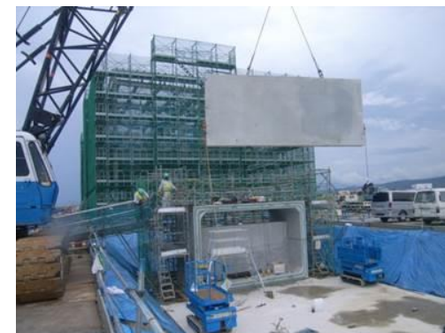
端部閉塞版設置
