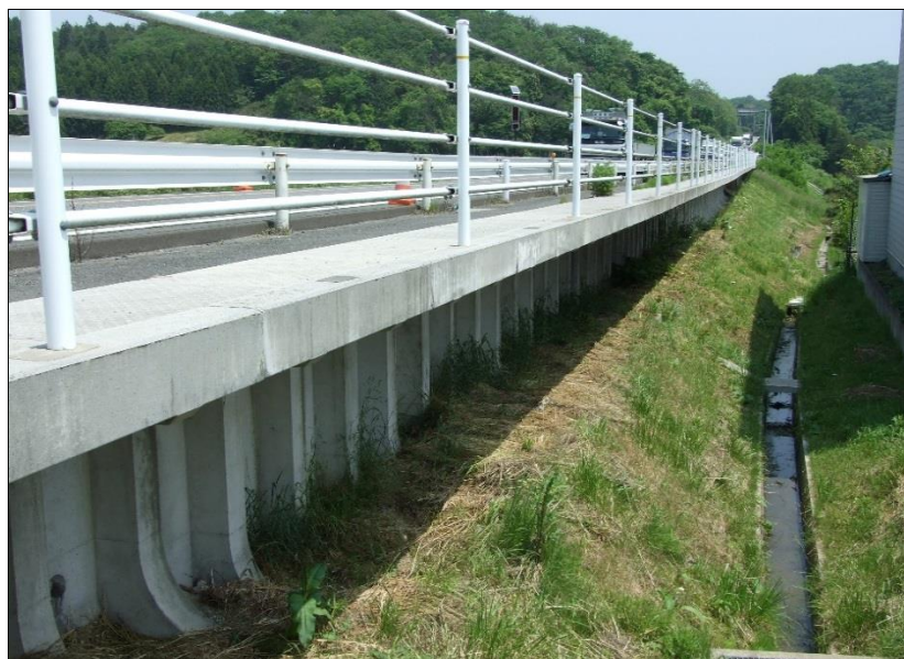
施工事例1(盛土部に設置)
