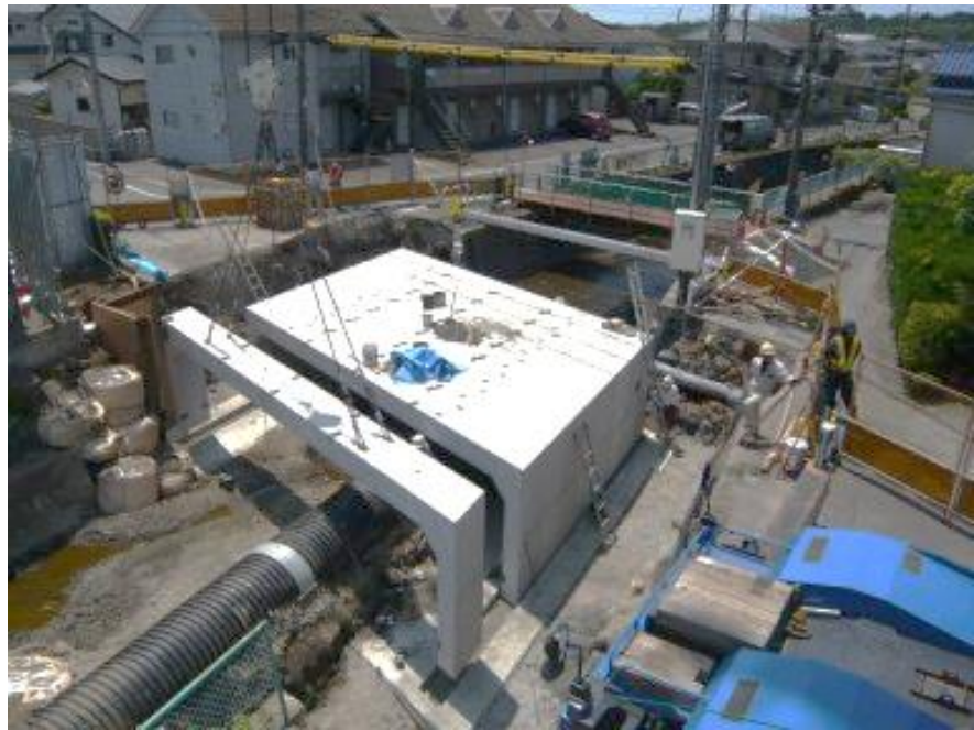
ブロック施工状況
