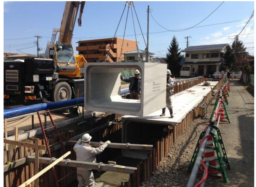
ブロック据付状況
