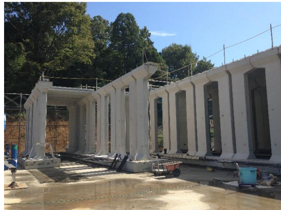
スタンド型施設の施工状況 ②
