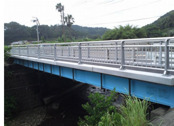
幅2600mm×厚さ320mm×長さ3120mm (歩道幅2000mm、最少厚60mm)
