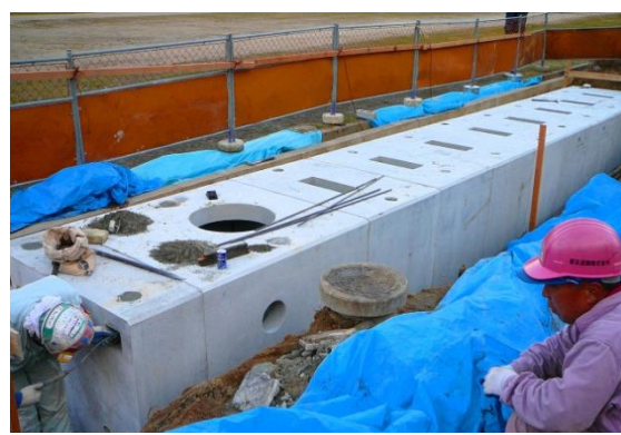
サイレット施工状況
