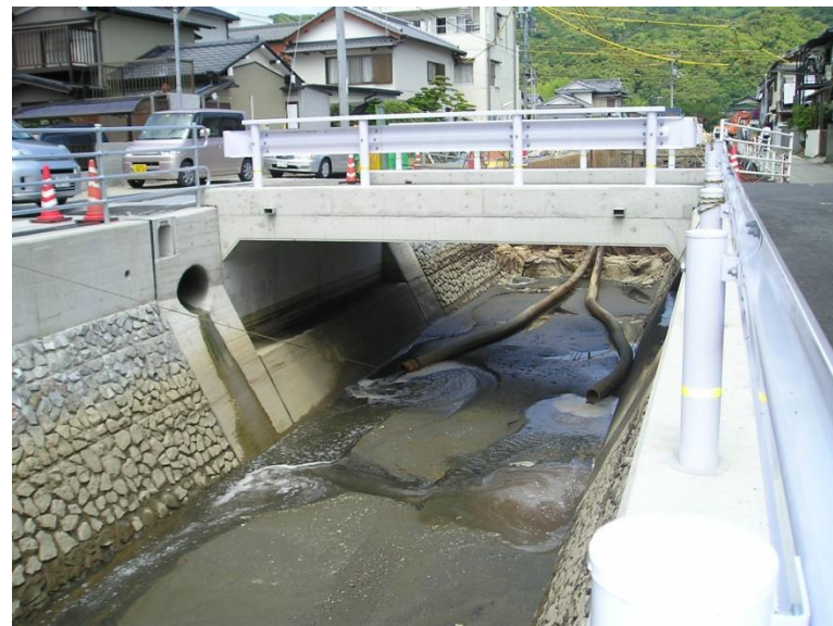
設置完了、供用後状況
