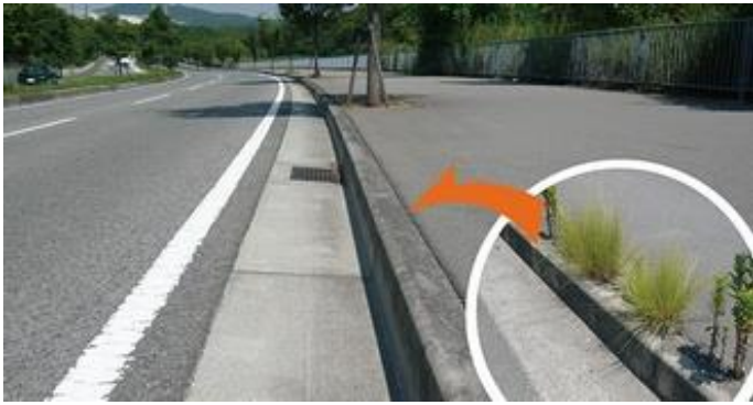
従来のエプロン施工状況
