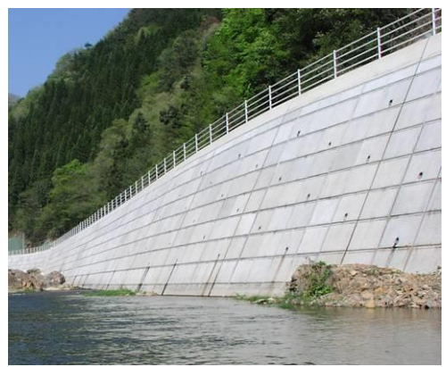
もたれ式擁壁施工事例
