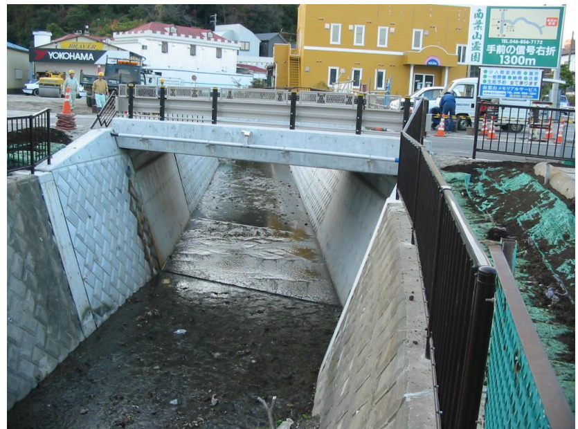
橋梁完成状況
