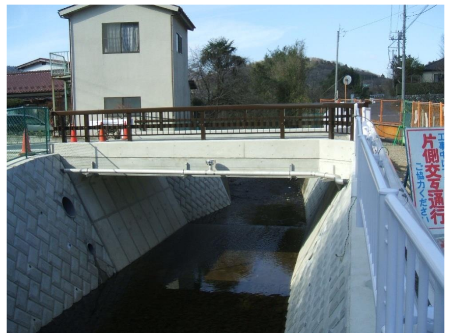
橋梁完成状況
