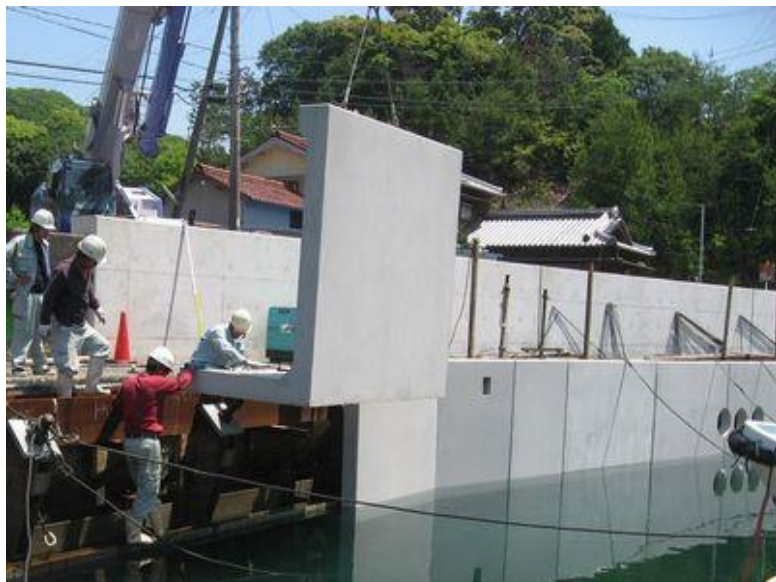
パネル施工状況
