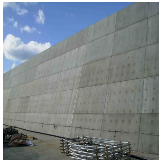
津波津波防波壁嵩上げ施工
