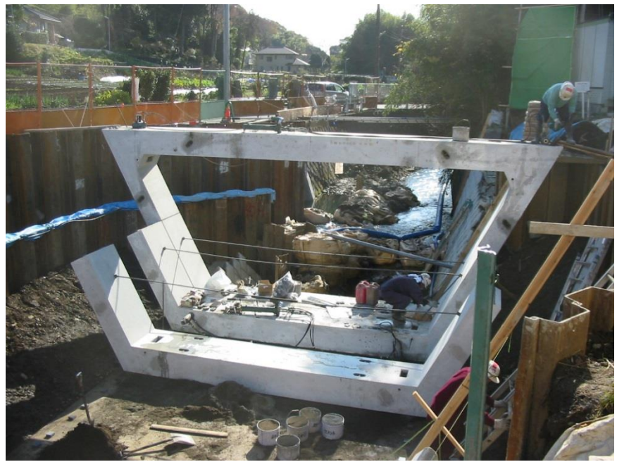
ブロック施工状況
