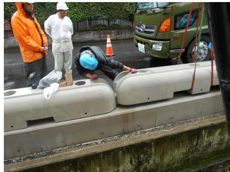
スリングロープによる吊施工状況
