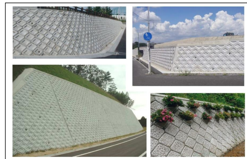
フヘキ5号(施工写真)
