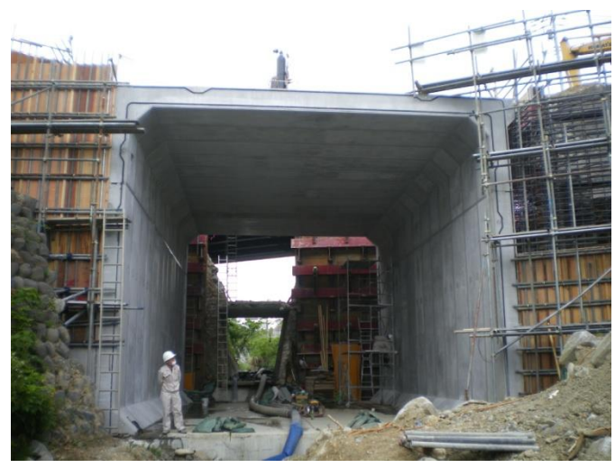
底版部施工完了状況
