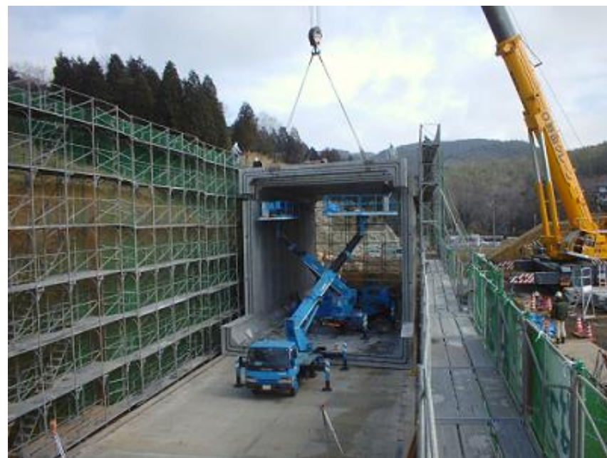
平行四辺形(4分割)ボックスカルバート (内幅)9250mm(内高)9000mm(長さ)1200mm
