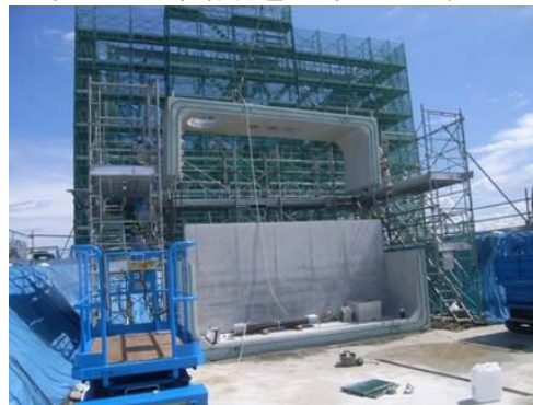
越流部上部ボックス設置
