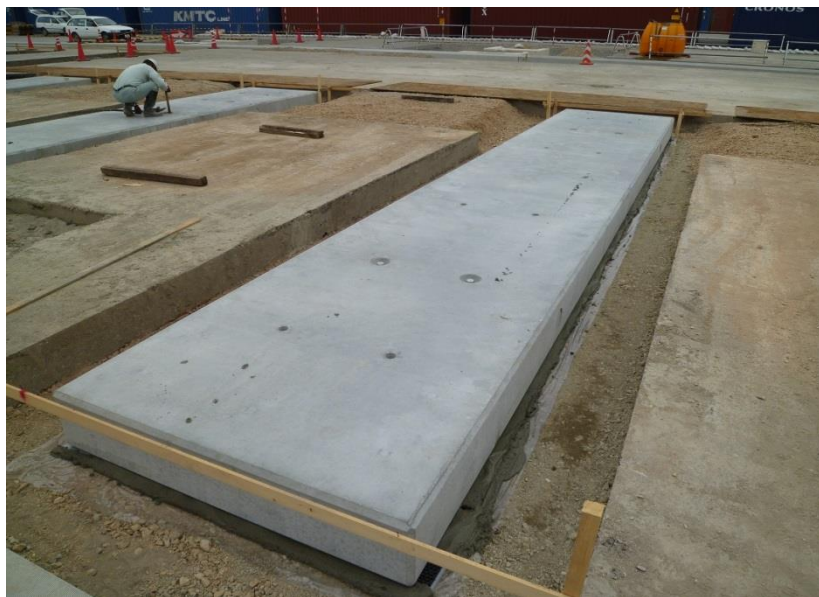
コンテナマット施工状況
