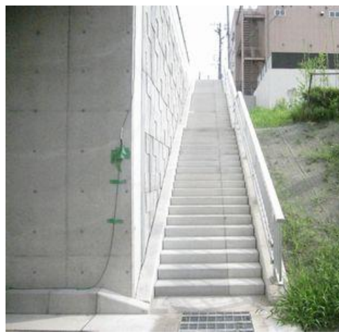
歩道階段完成写真 国道302号
