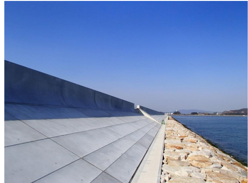
施工完成写真
