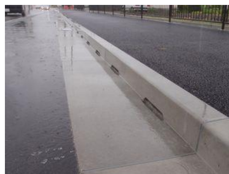
Rain catch エプロン排水状況
