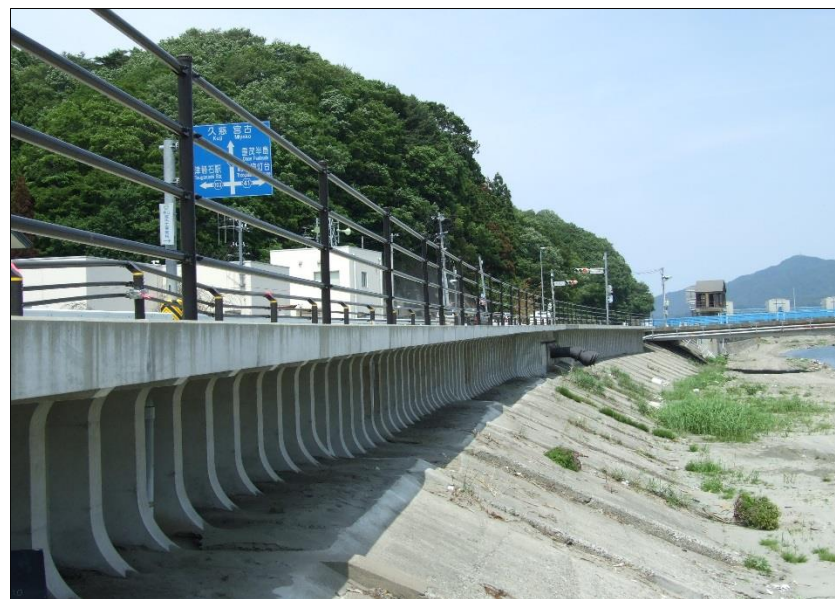
施工事例2(河川に設置)
