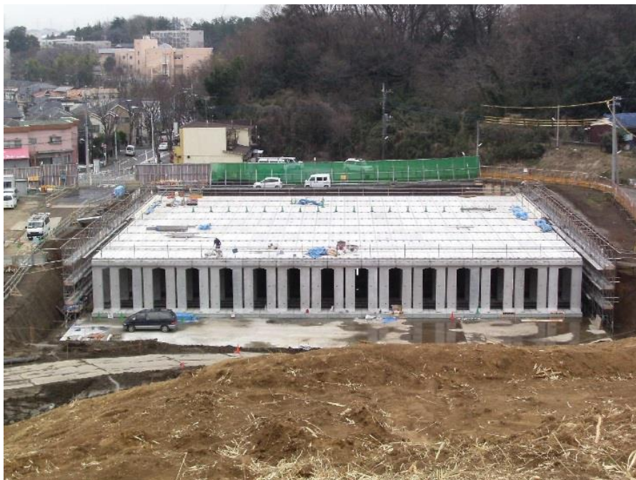
スタンド型施設の施工状況 ①
