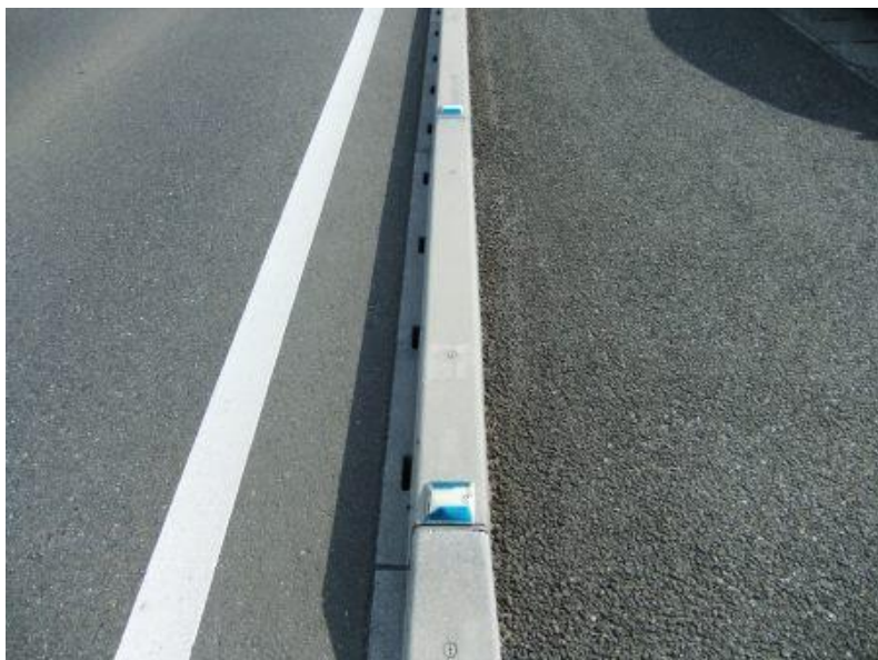
施工完了後(1年6か月経過)
