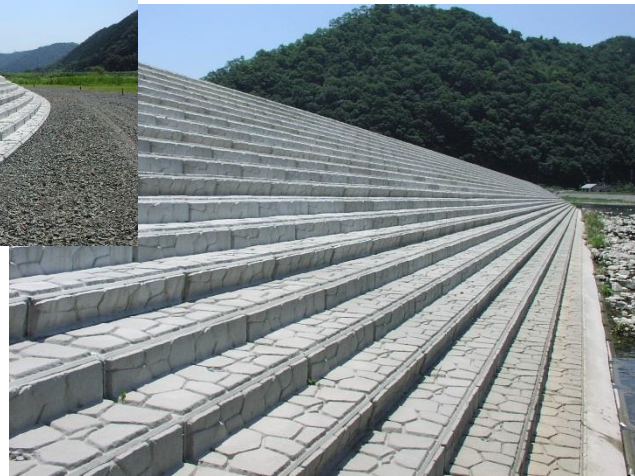
直線部の施工事例
