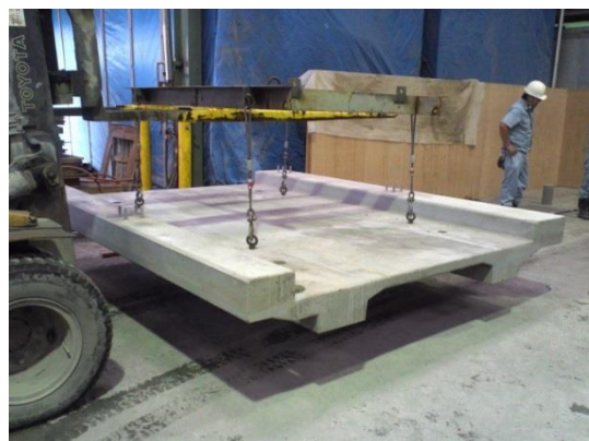
現場の施工延長を6分割(2731kg/枚)して工場で製作
