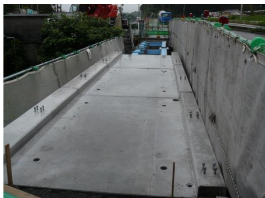
既設桁の補修実施後に敷設
