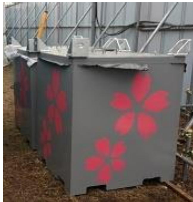
汚染土容器施工設置状況
