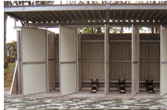
施工完了 (トイレ使用状況)
