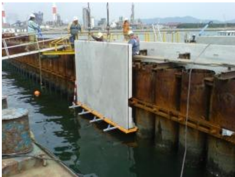
パネル施工状況
