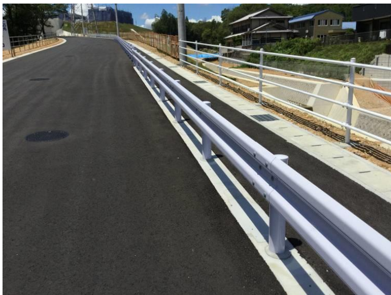
埋設式にて採用された事例
