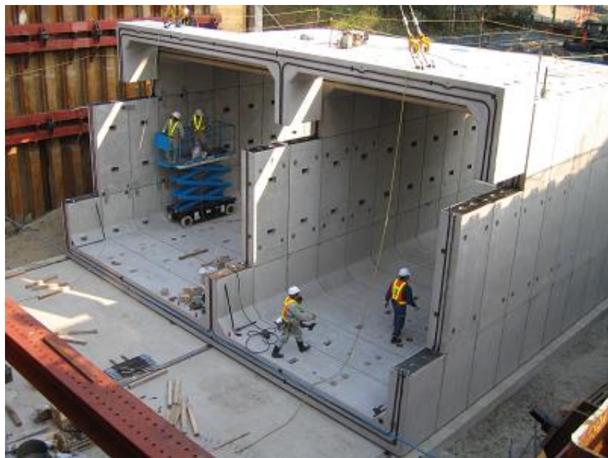
2連式(5分割)ボックスカルバート (内幅)5500+6580mm(内高)5400mm(長さ)1129mm
