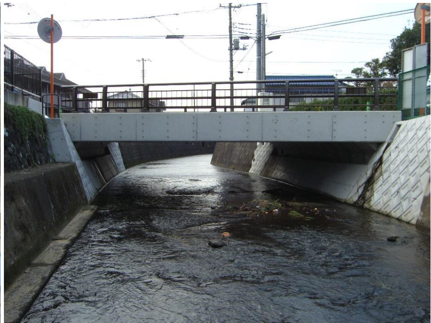
橋梁完成状況
