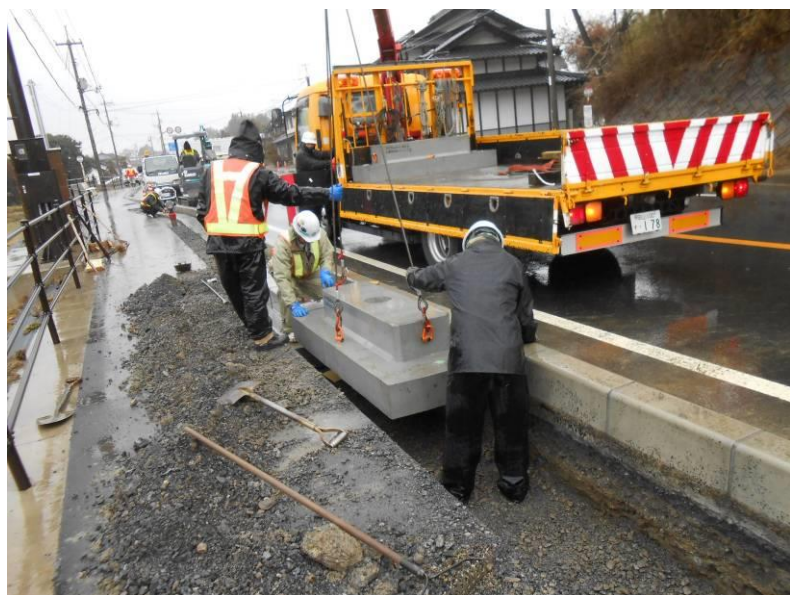
ブロック施工状況
