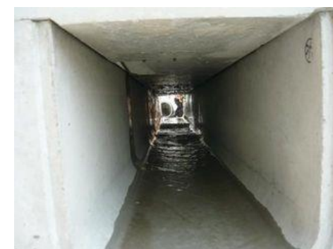
Rain catch エプロン内排水状況
