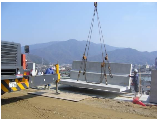
ブロック施工状況
