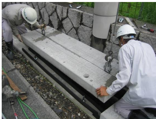
蓋版設置状況
