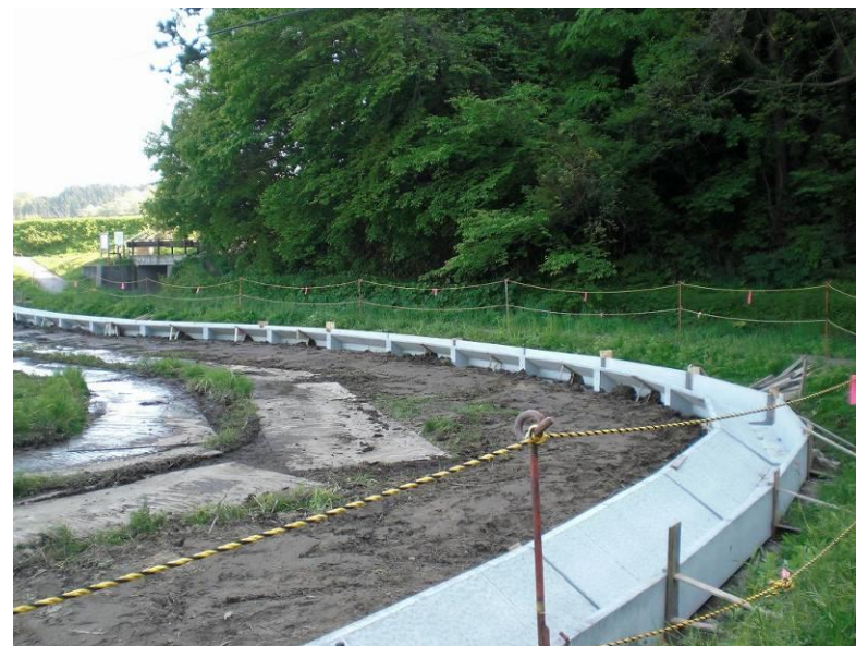
側溝設置状況 (路外側に脱出)
