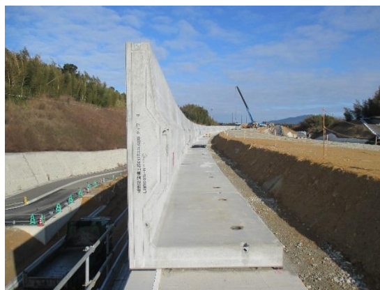
ブロック施工状況
