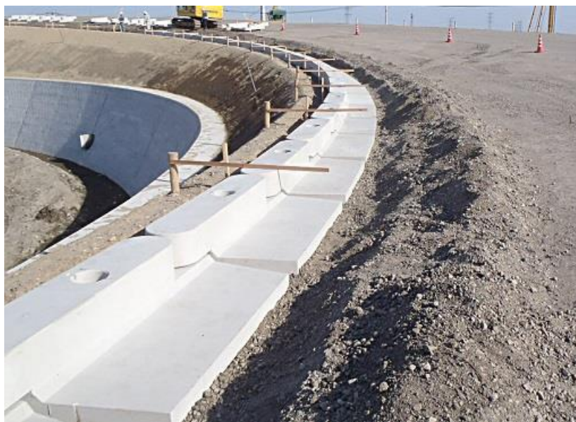
基礎施工状況
