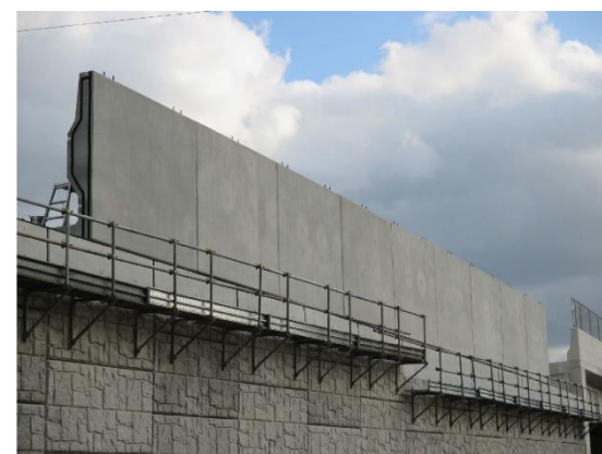
ブロック施工状況
