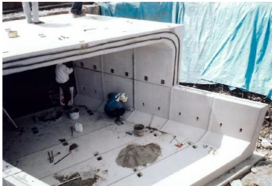
ブロック施工状況
