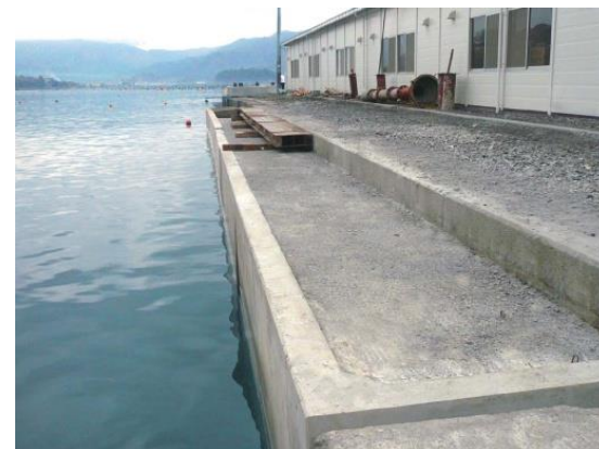
施工完了状況
