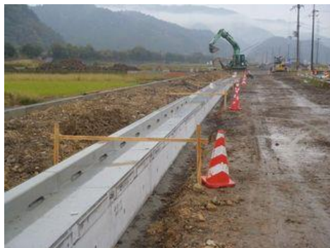
Rain catch エプロン施工状況
