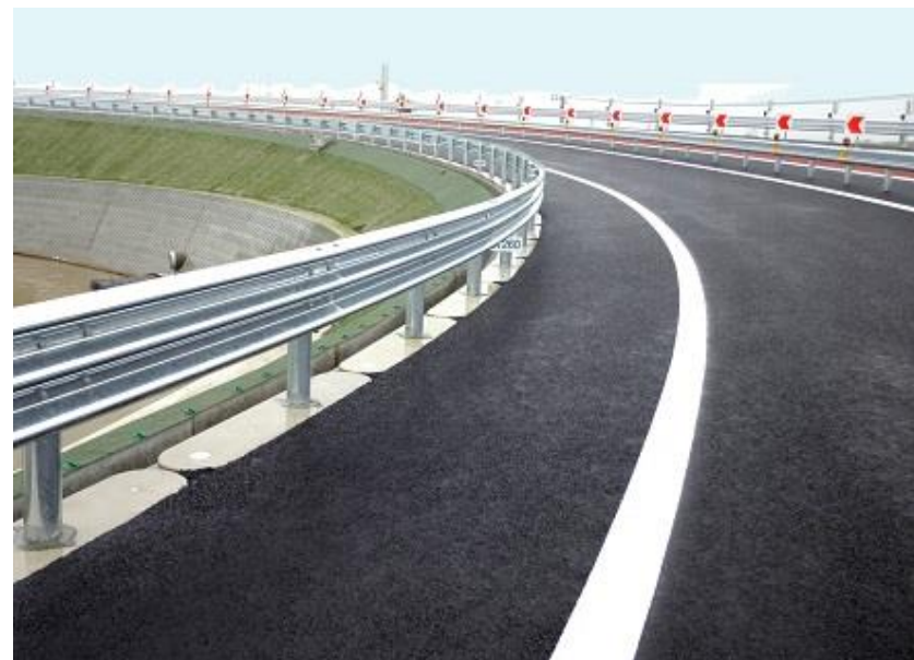
基礎施工完了
