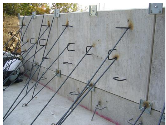
パネル施工状況
