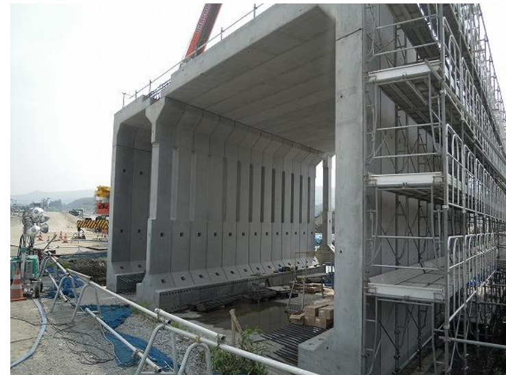
施工状況(製品据付)
