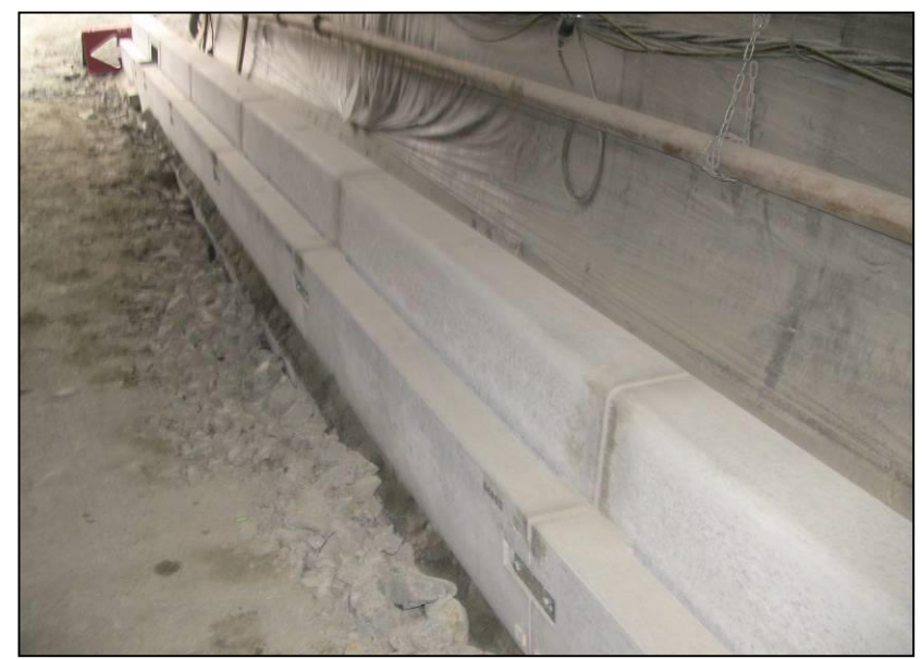
トンネル用スリット側溝設置完了
