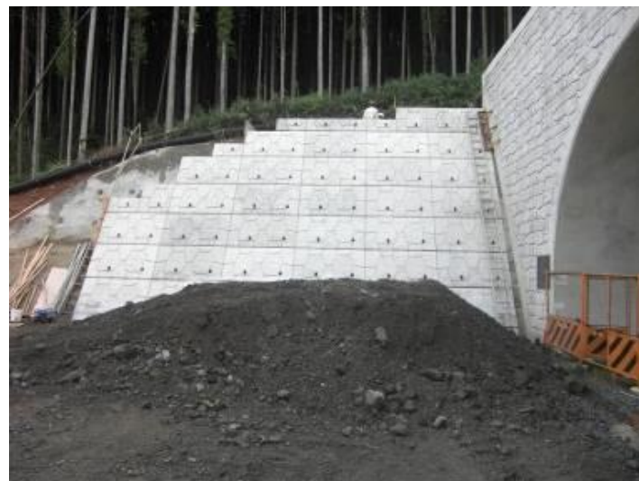
トンネルの坑口の山留として採用された事例
