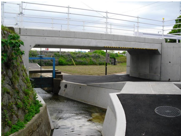
設置完了、供用後状況
