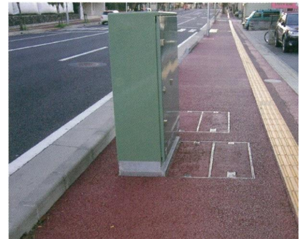
アスコン舗装例
