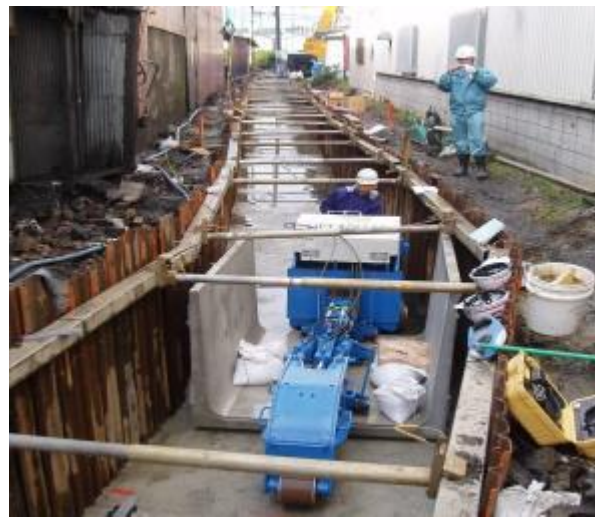
三面水路施工状況
