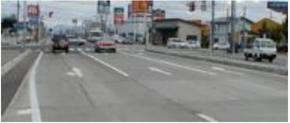
舗装版(明かり部)使用状況
