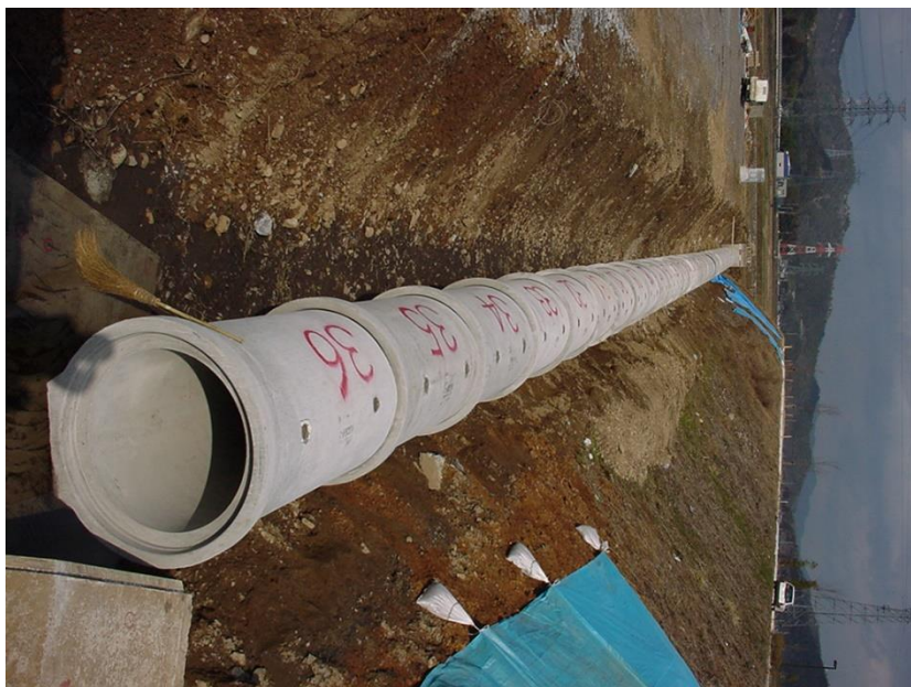
バイコン台付管 施工状況
