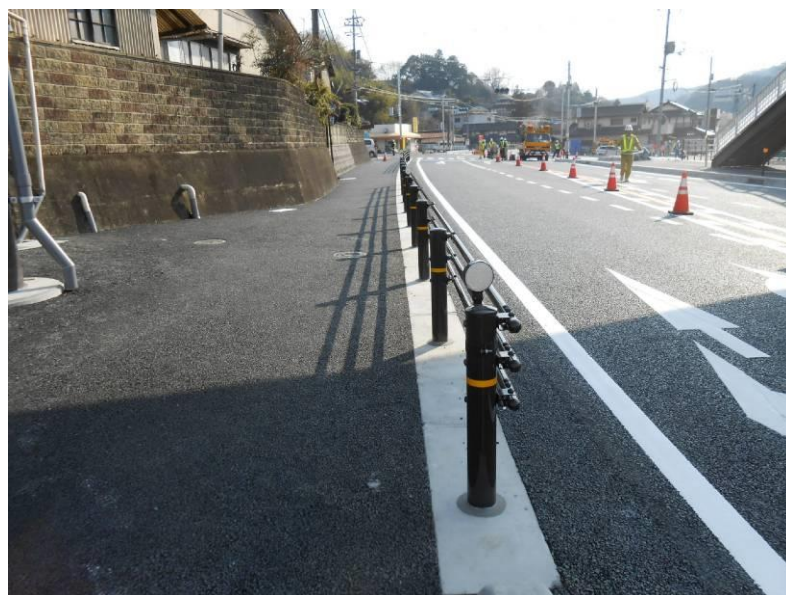
道路供用状況
