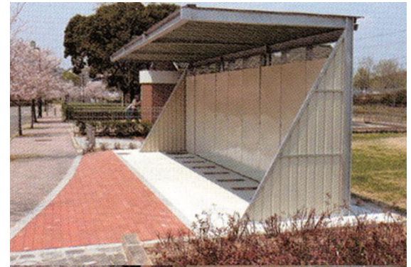
施工完了 (上部は駐輪場)
