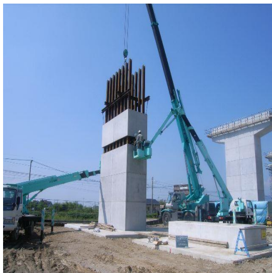
橋脚急速施工
