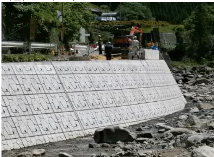
河川護岸兼路側擁壁として採用された事例
