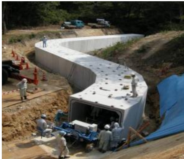
BOX施工状況
