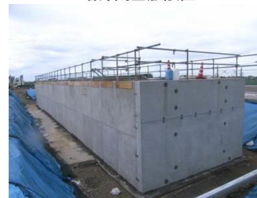
貯水槽 施工完了
