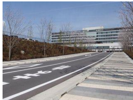
Rain catch エプロン施工完了
