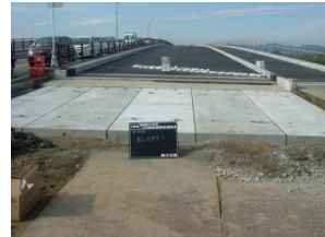
国道351号 大手大橋踏掛版
