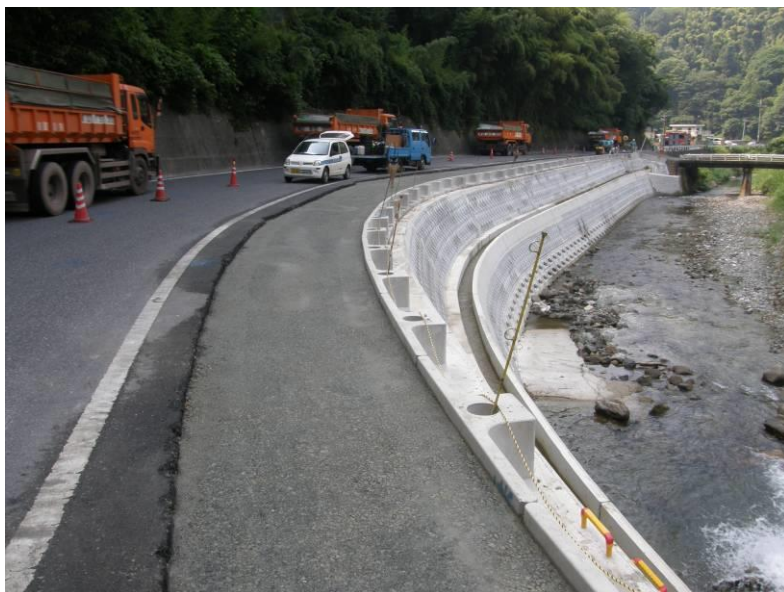
片側交互通行による施工状況
