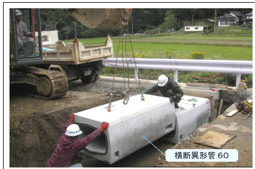
横断異形管60(道路横断工として使用)
