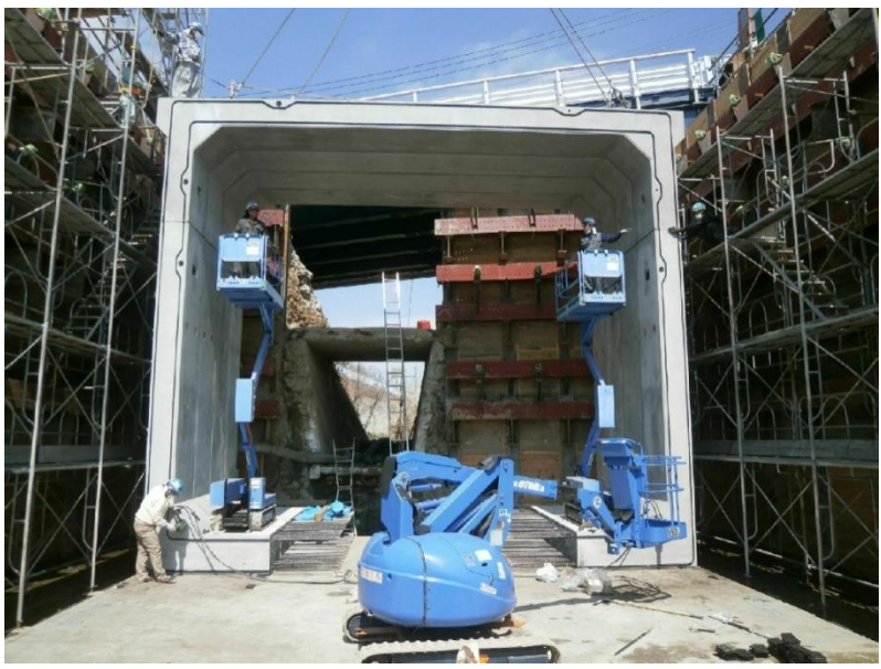
プレキャスト部組立施工状況
