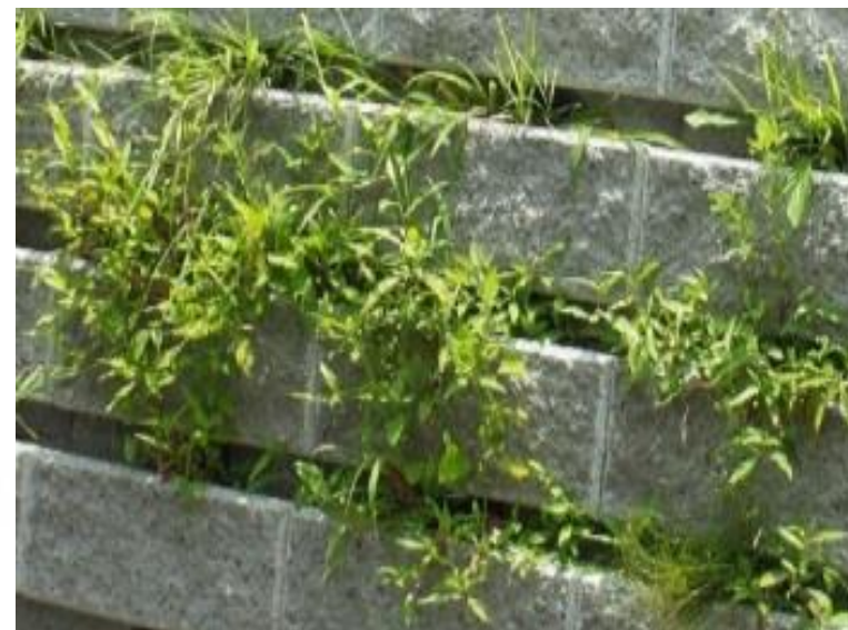
目地部の状況
