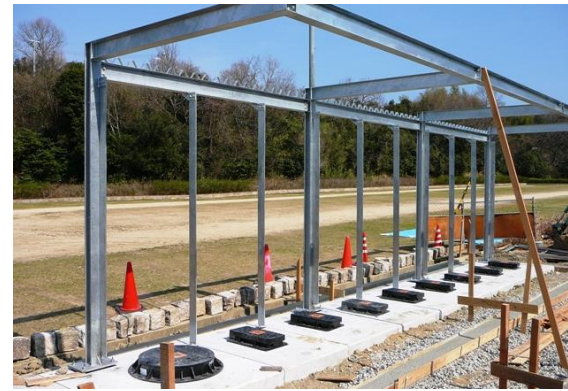
ETルーフ施工状況
