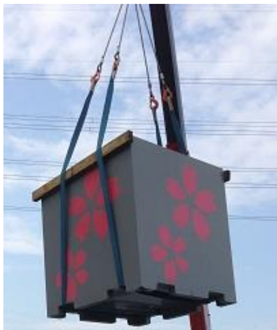
汚染土容器施工吊り上げ状況
