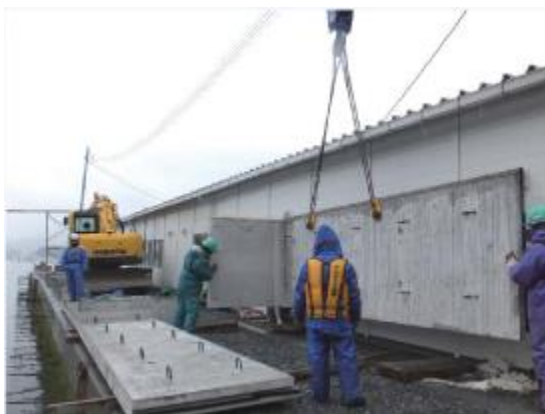
パネル設置状況
