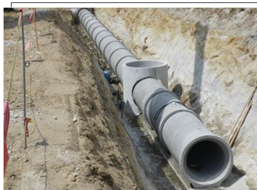
バイコン台付管 施工状況
