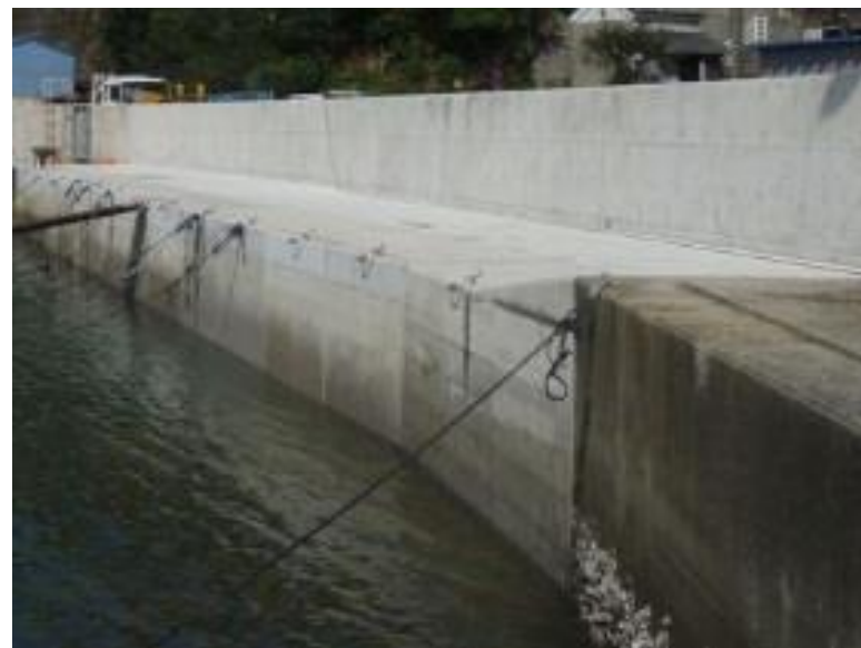
パネル施工完了
