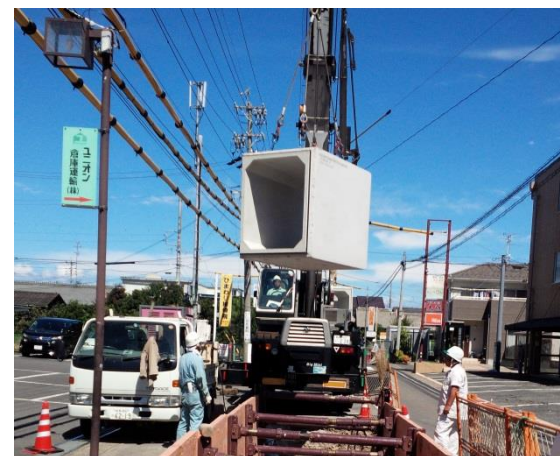
製品施工状況
