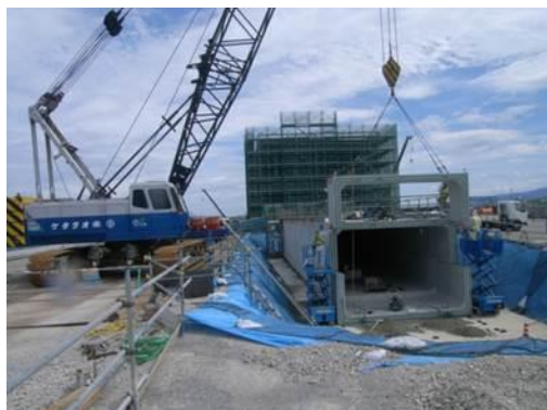
散水ポンプ設置部上部ボックス設置
