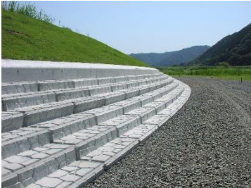
↑ 曲線部の の施工
