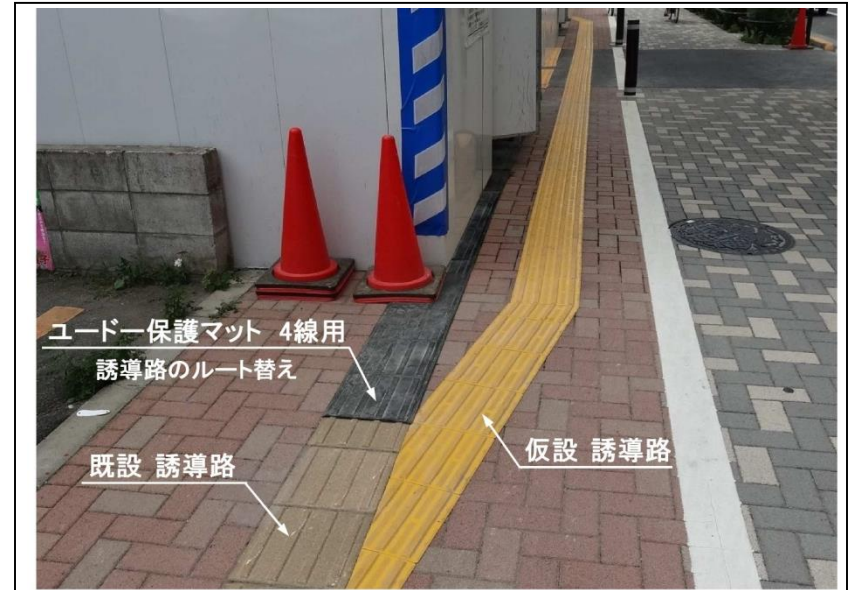
ユードー保護マット(施工写真)
