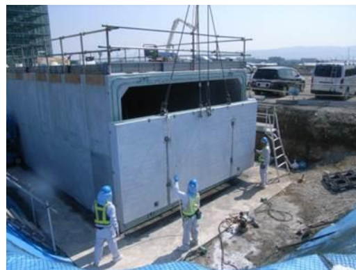
端部閉塞版設置
