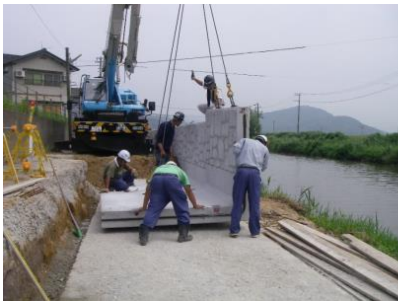
製品設置状況
