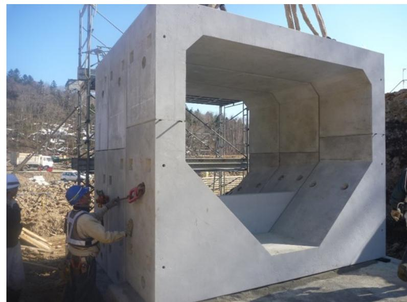
製品据付状況 (内空B:3.0m×H:2.7m)
