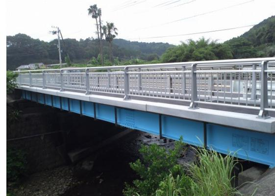
幅2600mm×厚さ320mm×長さ3120mm (歩道幅2000mm、最少厚60mm)
